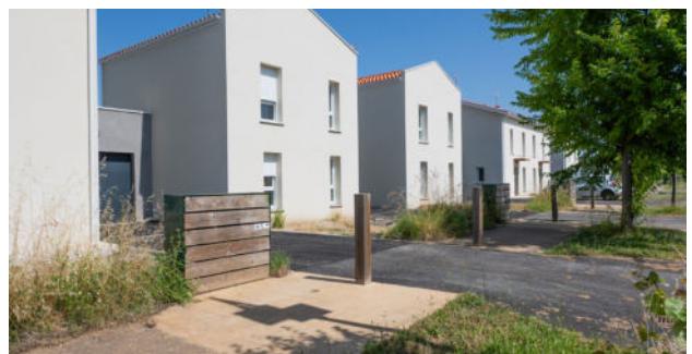
SAINTE-BAZEILLE RÉSIDENTE DES LILAS ÉCOQUARTIER 16 LOGEMENTS
