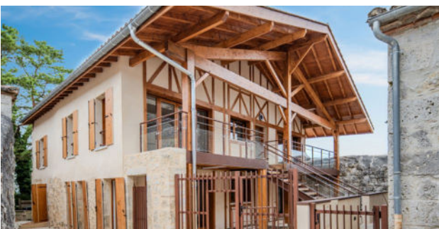
LAYRAC RÉHABILITATION 10 LOGEMENTS
