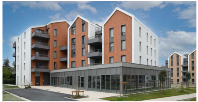
BRUGES HÉVÉA 8 LOGEMENTS
