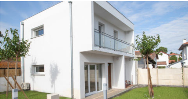
BOUCAU LES LAVANDIERS 8 LOGEMENTS
