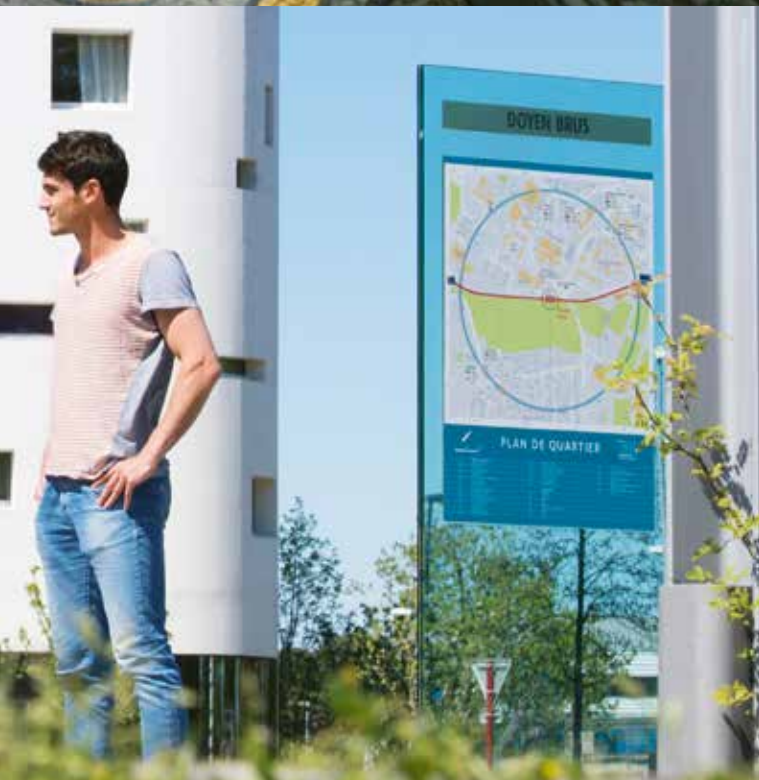
Réhabilitation de la résidence rue des 3 Conils à Bordeaux
